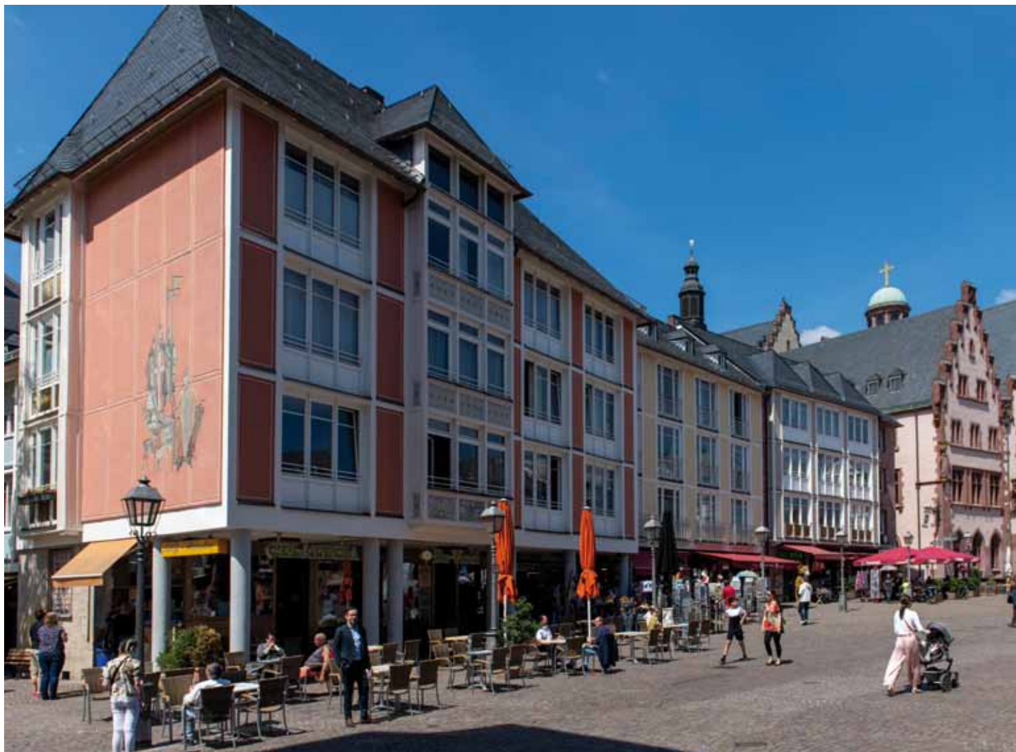
Bilder: Römerberg 11-17 Fassadenansicht und Detailansichten Frankfurt am Main
